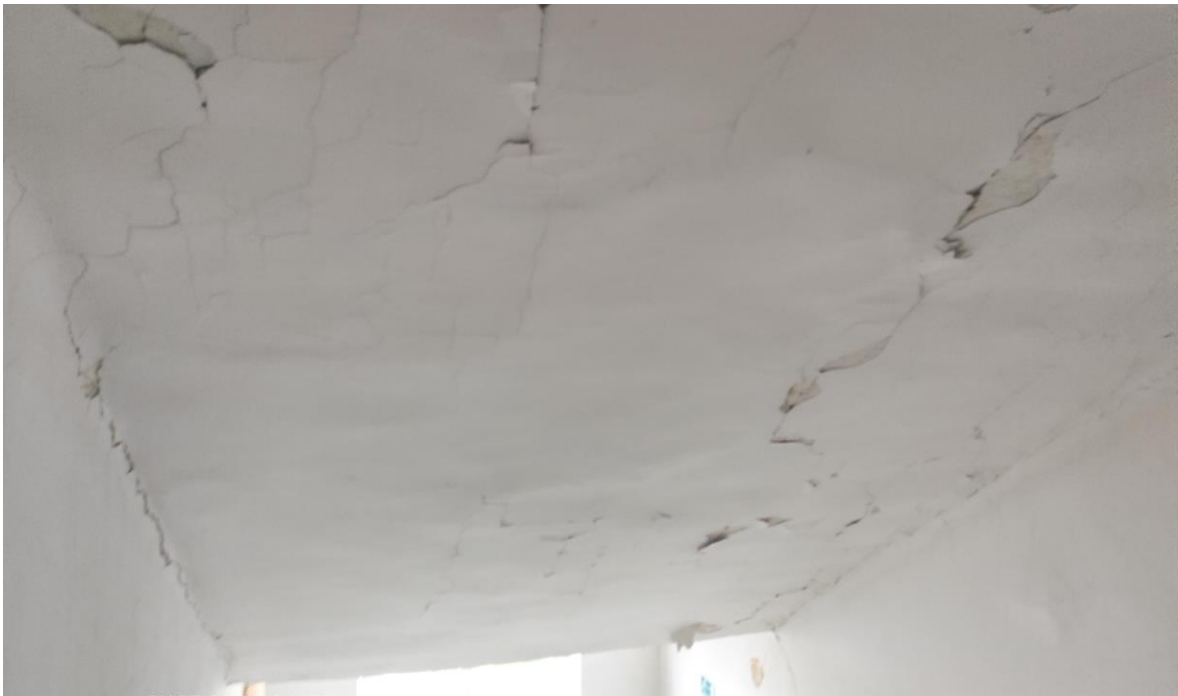
Otući staru žbuku i obraditi podgled knaufom
