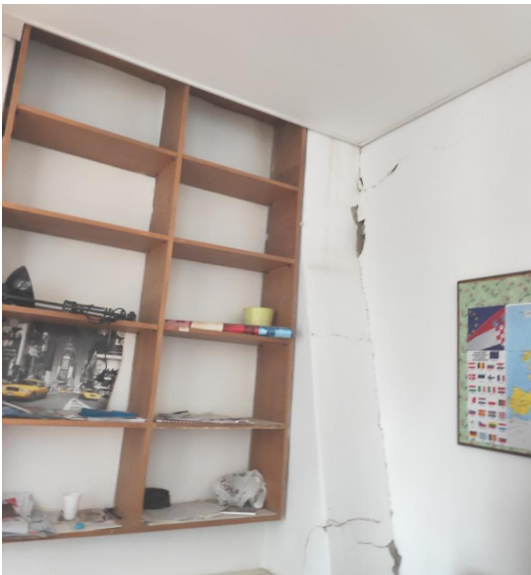
Skinuti oblogu od knaufa i sanirati zabatni zid cementnom žbukom s dodatkom staklenih vlakana s unutrašnje strane
