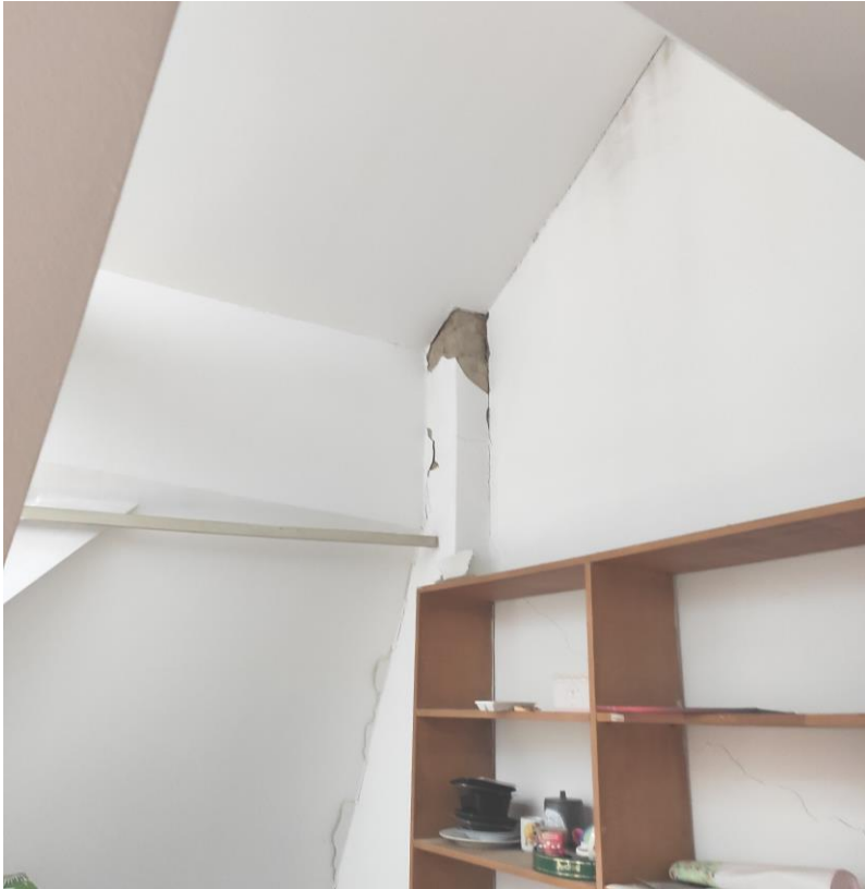
Skinuti oblogu od knaufa i sanirati zabatni zid cementnom žbukom s dodatkom staklenih vlakana s unutrašnje strane
